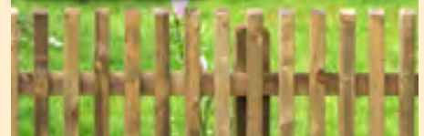
Montage vor Pfosten
