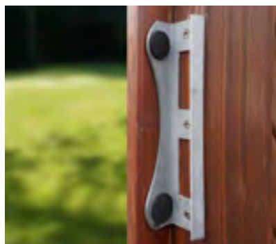
Einbau des Anschlagwinkels bei Toren Gehflügel DIN-links
